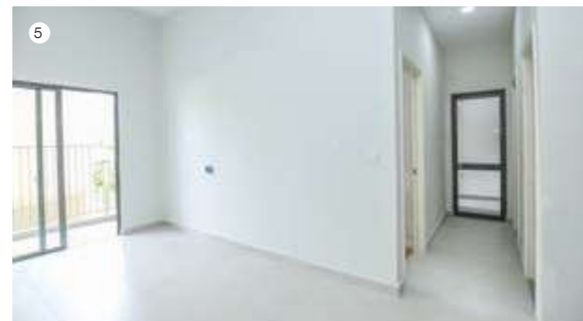
1. Toàn cảnh dự án 2. Cát nóc tòa nhà 3,4,5. Thi công hoàn thiện căn hộ
