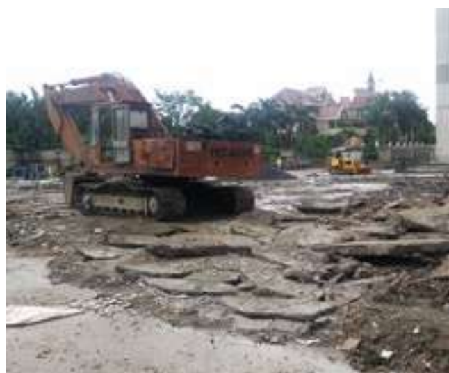
TRIỂN KHAI THI CÔNG HỒ ĐIỀU HÒA Constructing pond
