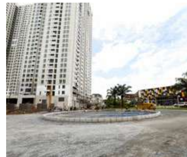
TRIỂN KHAI THI CÔNG LỐI ĐI NỘI BỘ Constructing internal roads
