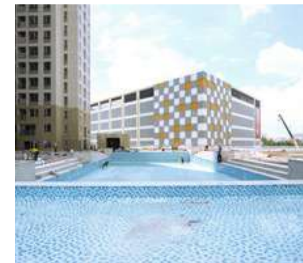
TRIỂN KHAI THI CÔNG HỒ BƠI Constructing pools
