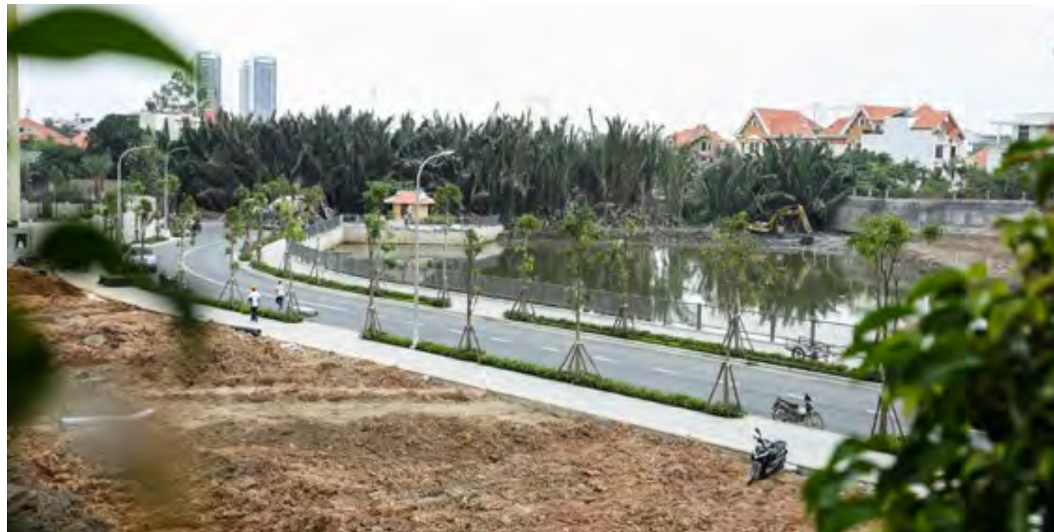
Thi công hồ điều hòa Constructing pond
