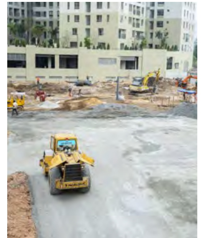
Thi công công viên cây xanh Constructing greenery park
