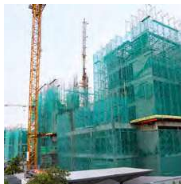
Toàn cảnh dự án đang thi công Project overview
