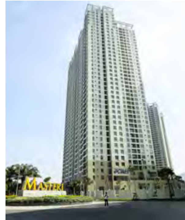
TÒA T3: Hoàn thiện cơ bản và đang đi vào hoạt động T3 Tower: Semi finishing and ready for using
