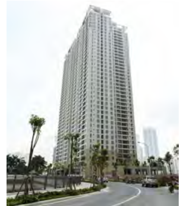
TÒA T4: Hoàn thiện cơ bản và đang đi vào hoạt động T4 Tower: Semi finishing and ready for using
