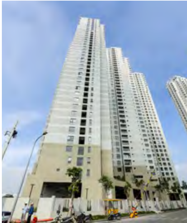
TÒA T1: Hoàn thiện cơ bản và đang đi vào hoạt động T1 Tower: Semi finishing and ready for using
