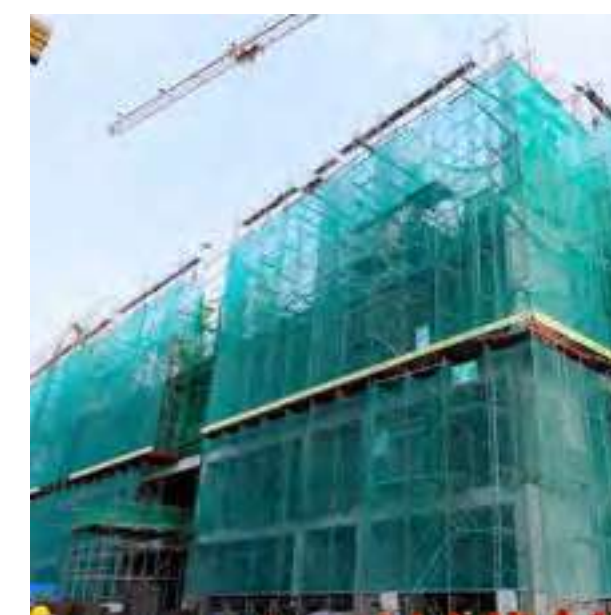
Tòa 2: Thi công đến tầng 7 Tower 2: Constructed to 7 th floor
