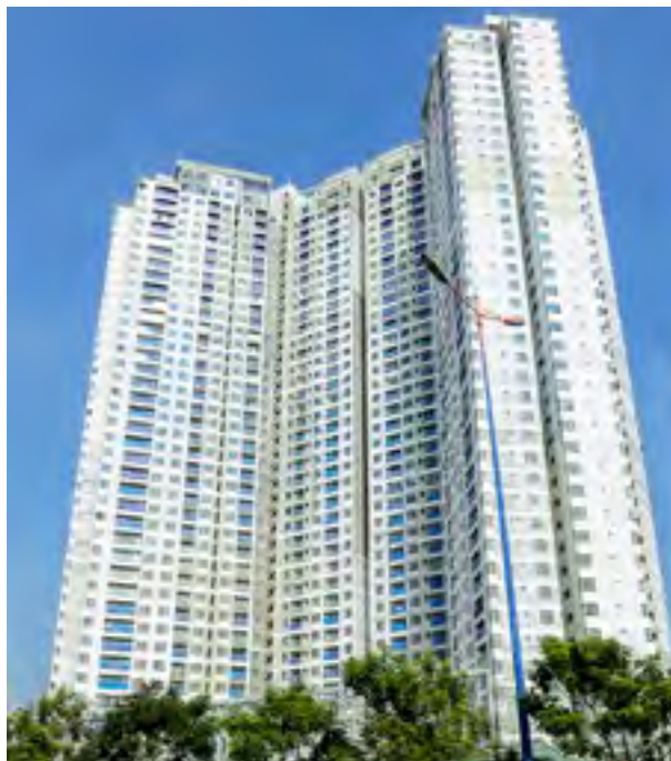
TÒA CĂN HỘ - DỊCH VỤ - THƯƠNG MẠI: Sơn nước đến tầng 30 The Apartment - Service - Commercial Tower Exterior elmusified painting to 30 th floor
