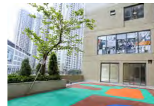
Thi công khu vui chơi trẻ em ngoài trời Constructing kid's outdoor playground
