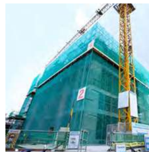
Tòa 1: Thi công đến tầng 5 Tower 1: Constructed to 5 th floor
