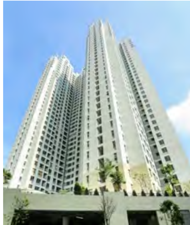
TÒA T2: Hoàn thiện cơ bản và đang đi vào hoạt động T2 Tower: Semi finishing and ready for using
