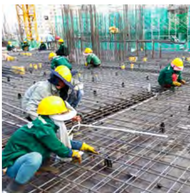
Công trường đang nhộn nhịp thi công Construction on progress
