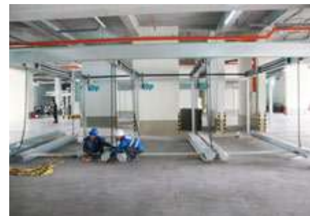
Hệ thống để xe thông minh Smart parking system
