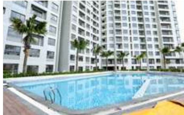
Tòa nhà Căn Hộ - Dịch Vụ - Thương Mại: Thi công hồ bơi The Apartment - Service - Commercial Tower: Swimming pool under construction
