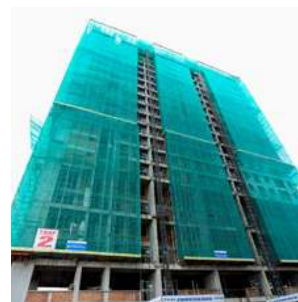
Tòa 2: Thi công đến tầng 22 Tower 2: Under construction to 22 nd floor
