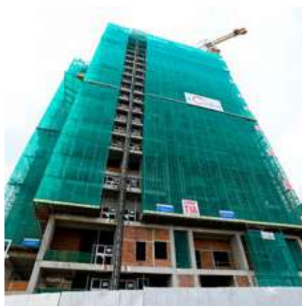
Tòa 1: Thi công đến tầng 21 Tower 1: Under construction to 21 st floor
